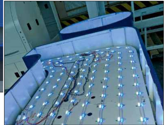
Leuchtbau belegte jede Anlage mit insgesamt je 5.538 weißen und blauen LEDs.
