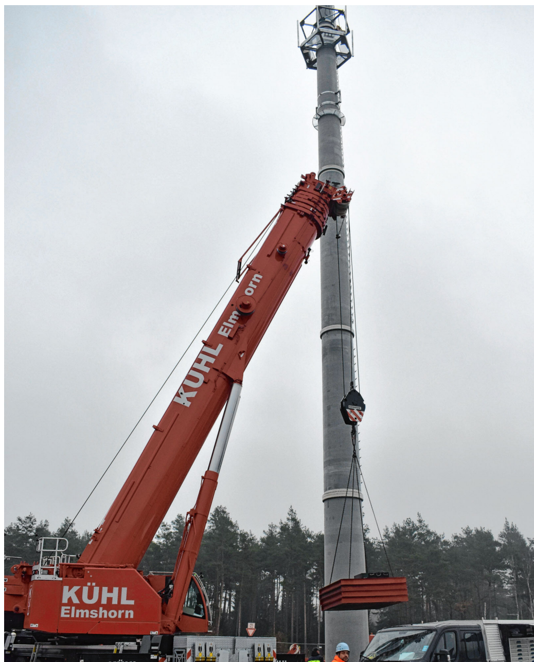
Mit einem speziellen Kran wurde der Werbeturm auf dem neuen Autohof an der A14 errichtet.
